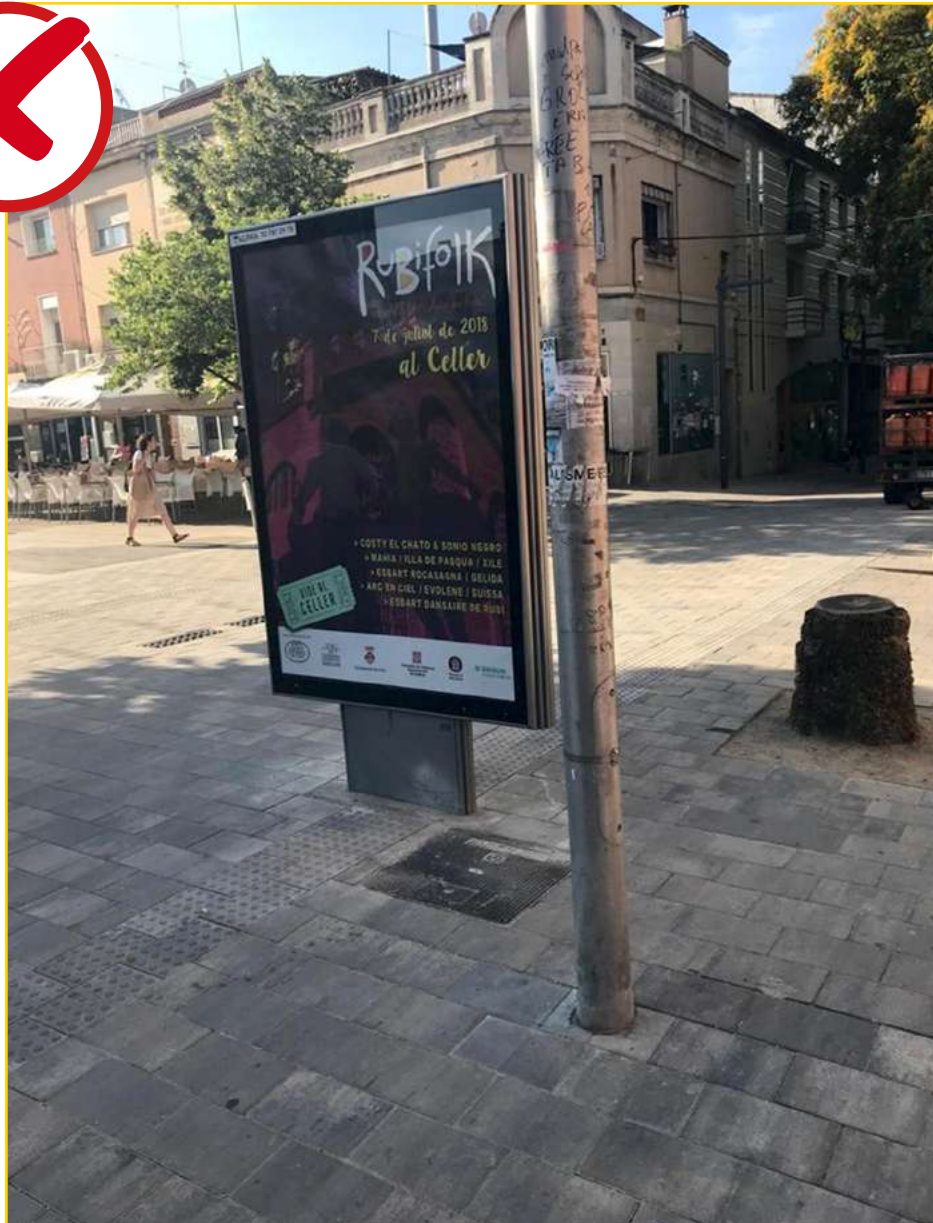
Imagen 17. Mobiliario urbano sobre el pavimento tacto-visual.
