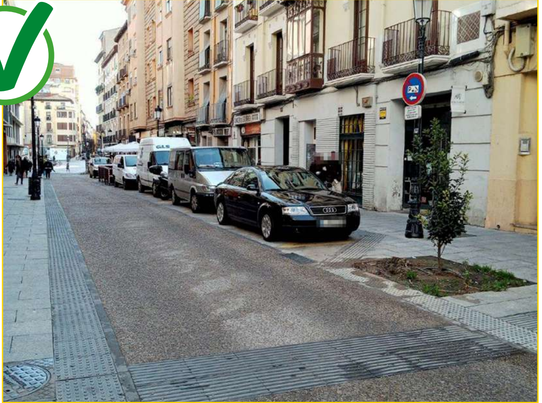
Imagen 41. Señalización que informa adecuadamente de la zona y condiciones del estacionamiento. Sin embargo, el pavimento tacto-visual no se acompaña de suficiente mobiliario delimitador.
