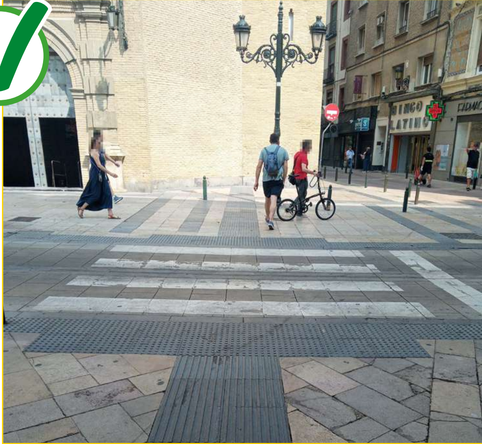
Imagen 38. Alineación correcta del pavimento direccional.
