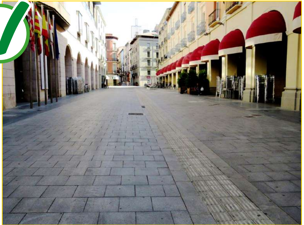
Imagen 14. Presencia de pavimento de acanaladura por imposibilidad de señalar la zona segura próxima a fachada.
