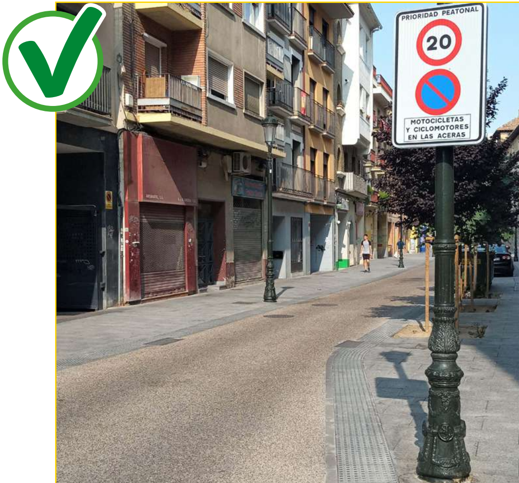
Imagen 40. Señalización apropiada que informa de las limitaciones a los vehículos. Sin embargo, el pavimento tacto-visual no se acompaña de suficiente mobiliario delimitador.
