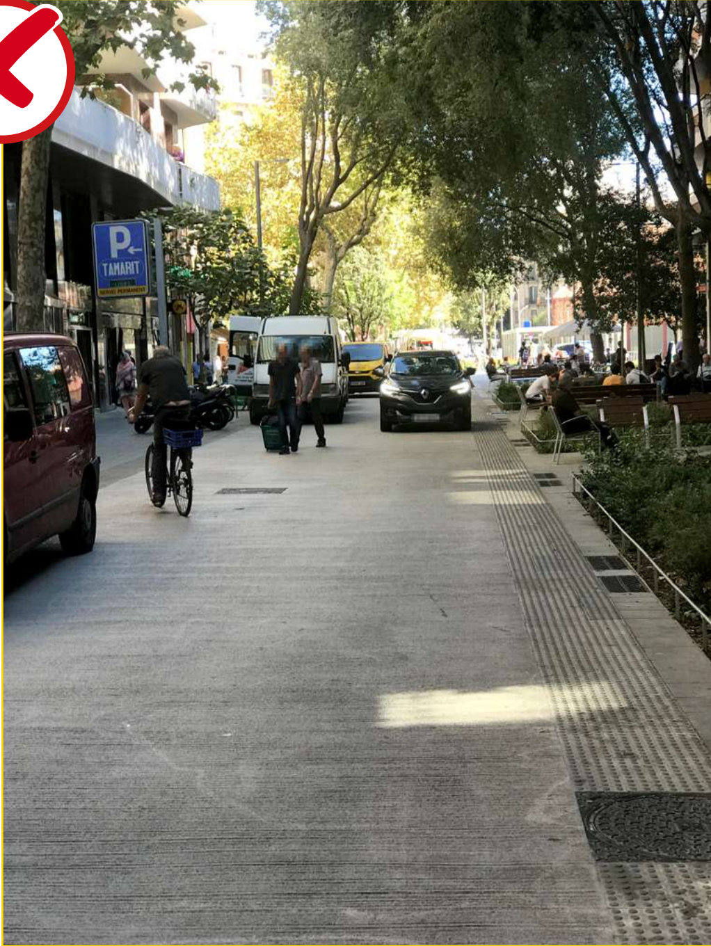
Imagen 29. Incorrecta colocación de franja de señalización de advertencia.
