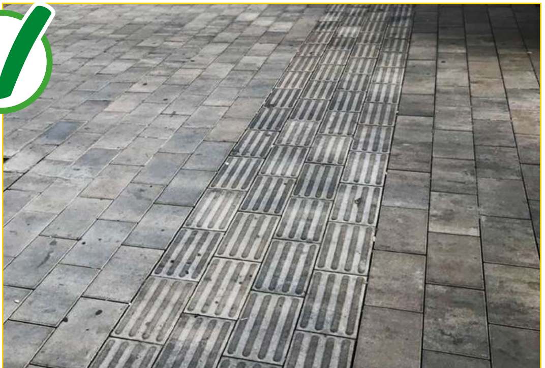
Imagen 16. Contraste adecuado de texturas entre el encaminamiento y el adyacente.
