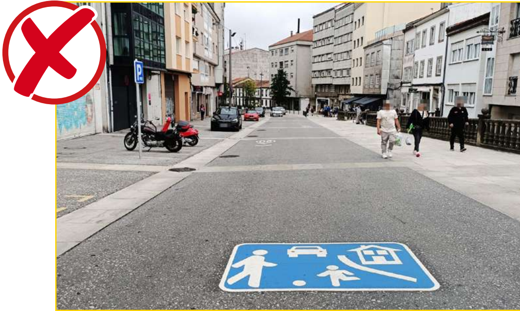
Imagen 39. Señalización inadecuada en plataforma de tránsito diferenciados, sugiriendo un uso compartido de ese espacio.
