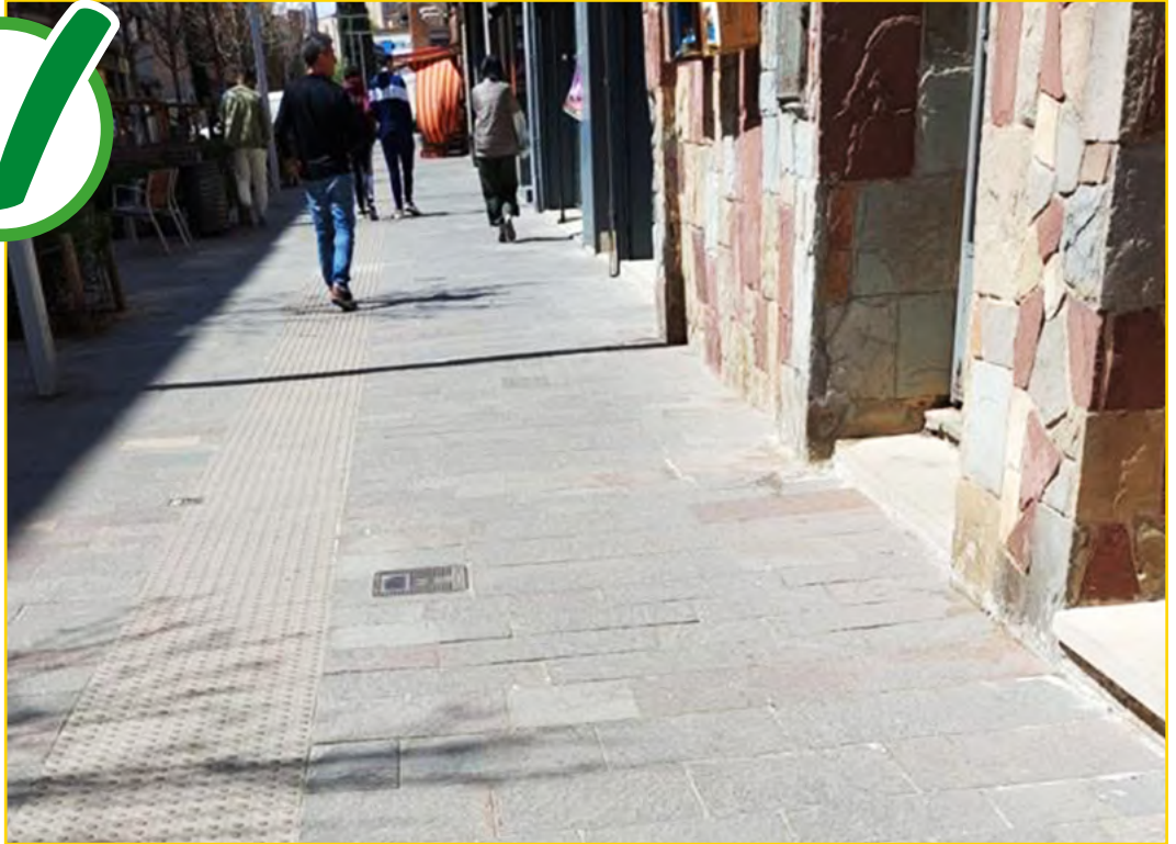
Imagen 15. Contraste adecuado de texturas entre el pavimento de advertencia y el adyacente.
