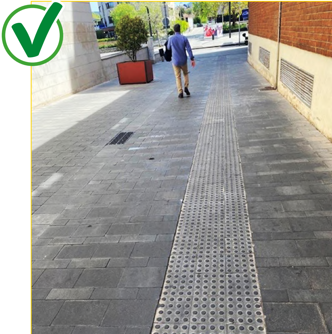
Imagen 12. Zona de mayor seguridad en un solo lado de la vía.
